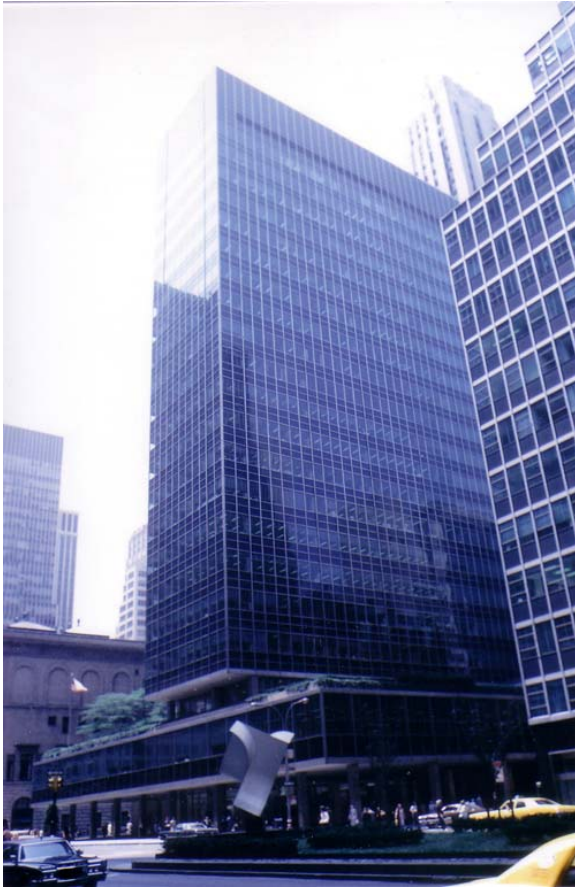
シーグラムの斜め向かい、レバーハウスのビル、SOM の設計
