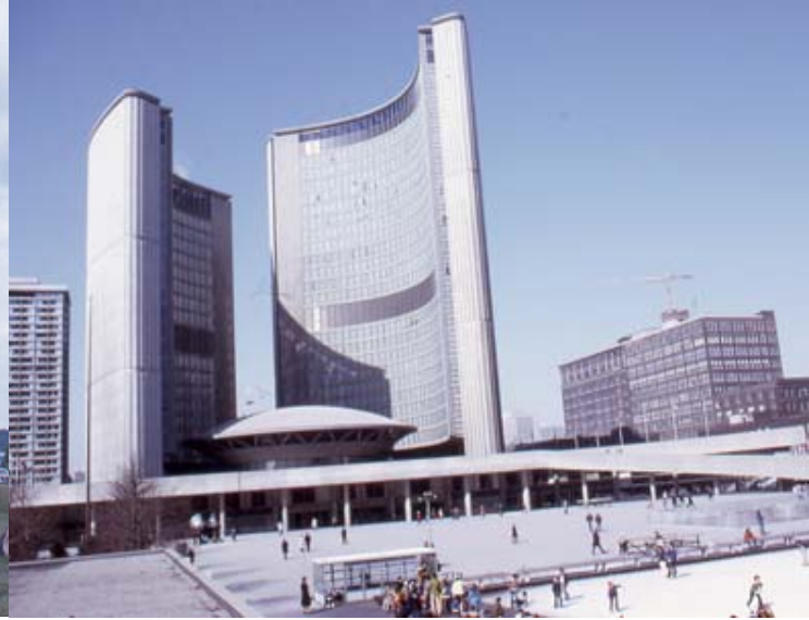
トロント市庁舎、カナダ、レヴェル設計 1959年 機能的には？だが綺麗なプロポーションの建築であった。
