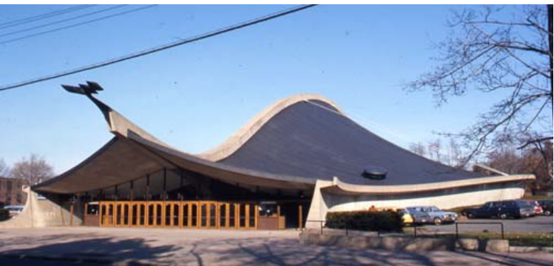
イエール大学アイスホッケーリング、サリネン設計—1958年 構造の圧縮と張力を利用して大空間を創り上げている。
