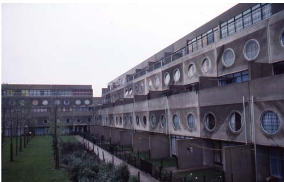
セントアンドリュース大学ハウジング、スコットランド、スターリング設計 1976年、プレキャストコンクリートパネルの円い窓が印象的だった。
