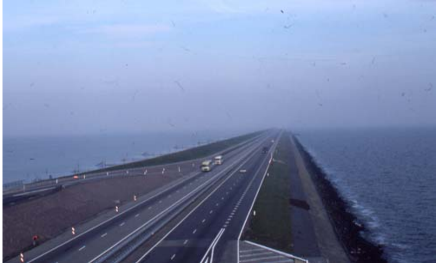
高速道路が海を断ち切り、海のかなたに高速道路が消えていく。
