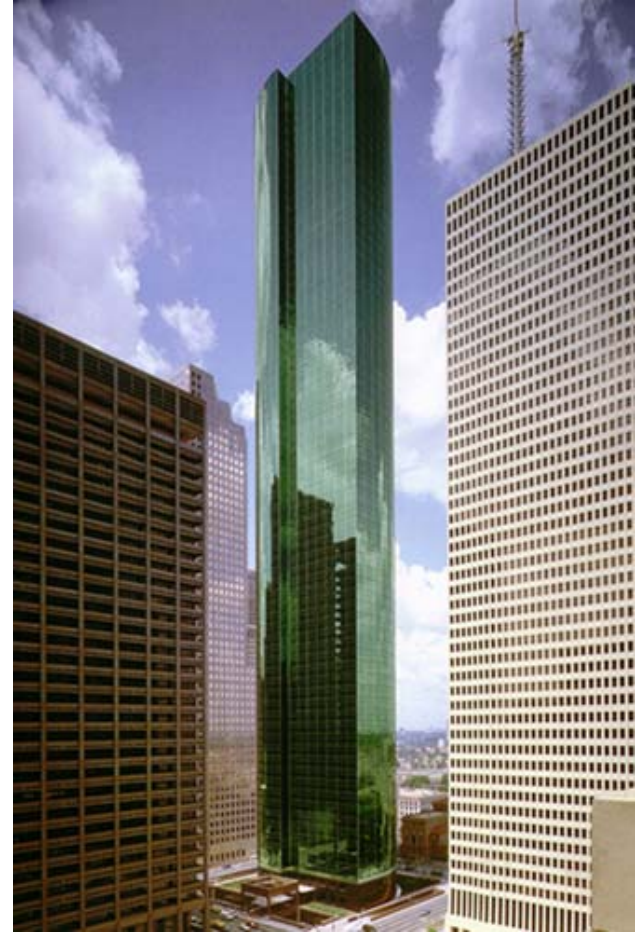
アライバンクプラザ、71階建ての事務所ビル、1979年、チューブストラクチャーシステム、グリーンのガラスで構造体を包む。
