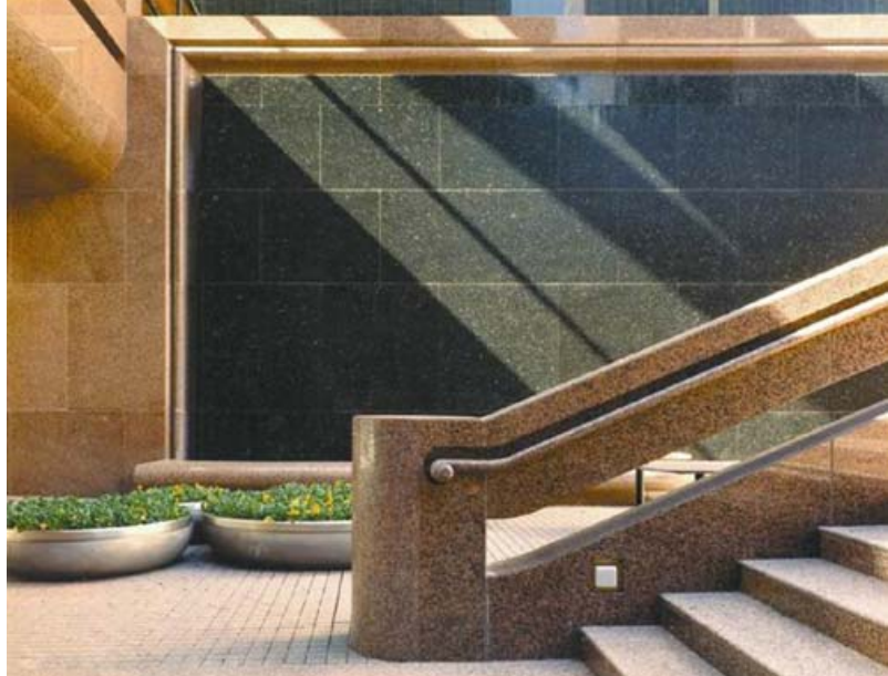
地下のプラザ、地上のプラザの階段の手すりは御影石を縋りぬいて造った。後ろの黒の御影石の壁は一面に水のシールの滝となっている。
