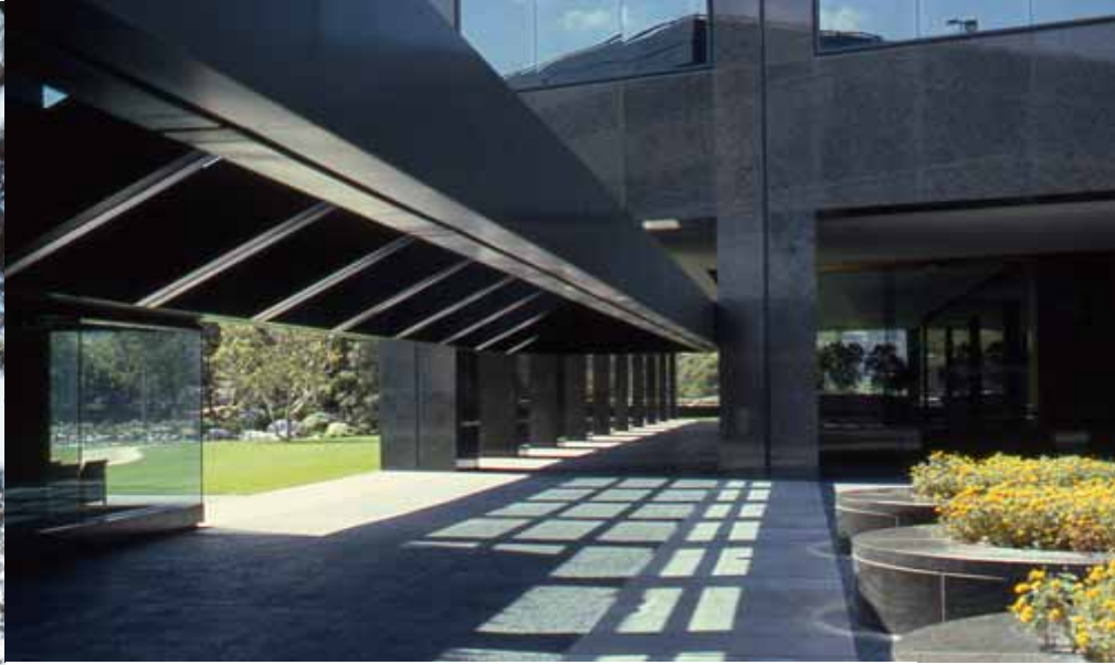
ゲートオフィスビルと私が担当した駐車場をつなぐキャノピー。重い御影石で造られたキャノピーが宙に浮いている。
