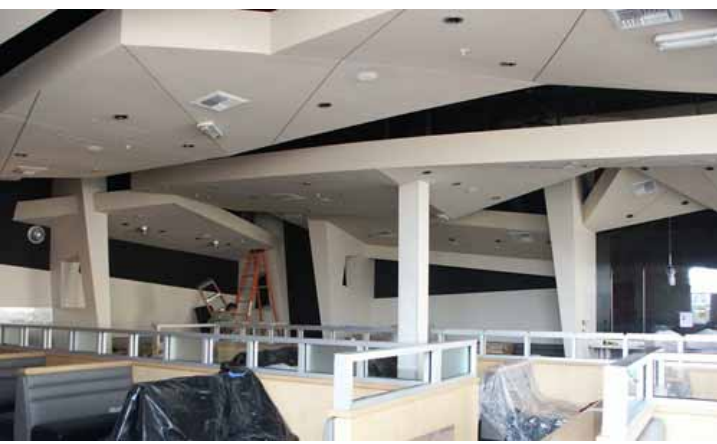
レストラン、歌舞伎、ラスベガス市、2000年設計、日本の折り紙のような複雑な天井と壁の工事現場。
