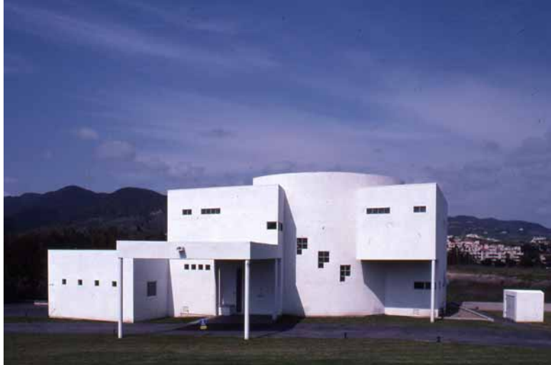
コンテンポラリーのホワイトハウス、マリブの家、1992年設計。交通が激しい表通りであったが市の規制でフェンスを作れなかった。騒音と強烈な西日を遮るために小さな開口部のガラスブロックだけの窓となった。バックヤード、反対側は大きな窓だけの家となった。
